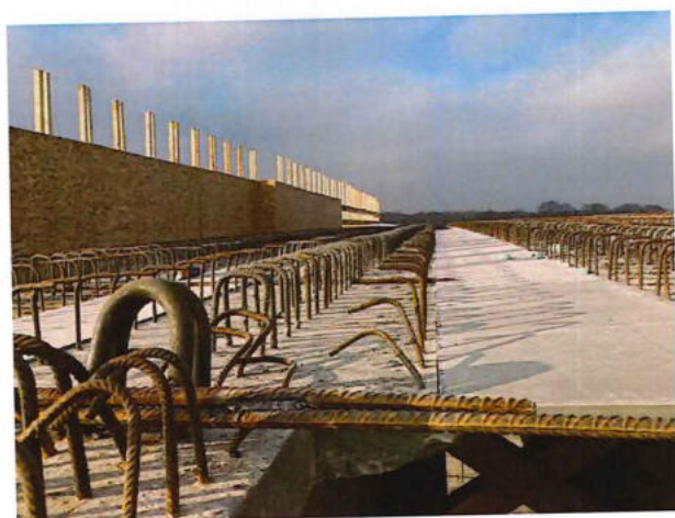
01-33-06 Montáž strateného debnenia
