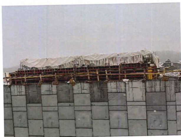
01-33-13 Armovanie a debnenie úložného prahu opory č.2
