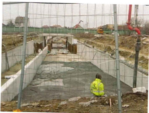
11-33-06 Armovanie, debnenie, betonáž žb vane
