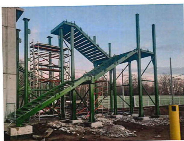
01-33-05 Montáž ocel'ovej konštrukcie schodísk
