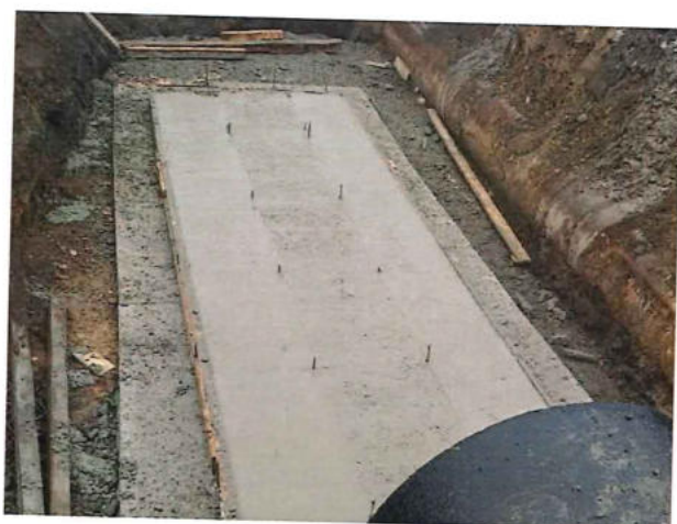
01-33-08 Betonáž základu a pokládka rúr
