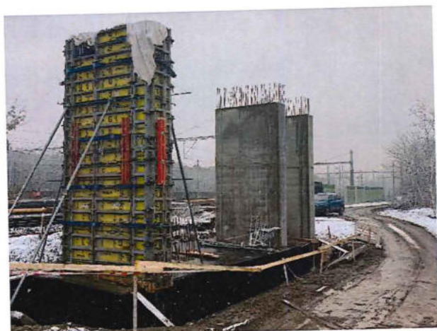
02-33-02 Debnenie piliera drieku opory č.1
